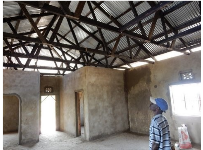
Der Kindergartenhauptaum während der Bauarbeiten im Juni 2016
